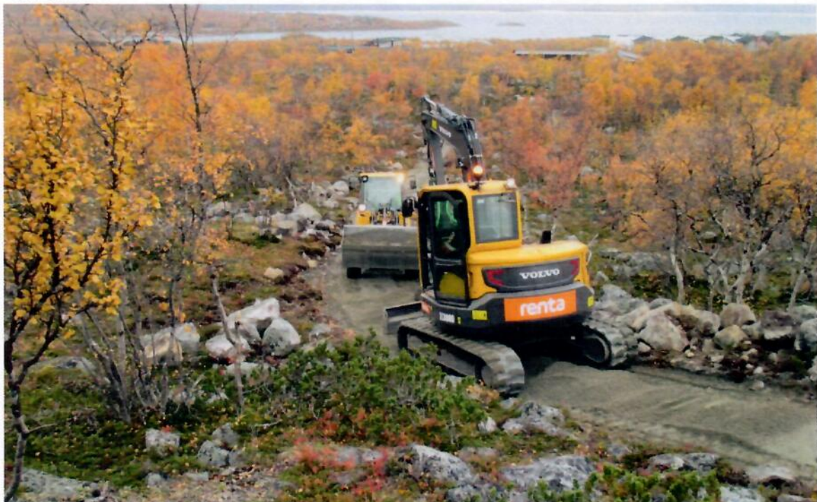
Polkujen kunnostusurakoitsijaksi valittiin Käsivarren Kuljetus Oy. Kuvassa kunnostettavalla polulla menossa pintamurskeen levitys Kyläkeskuksen ja Tsahkaljärven välisellä osuudella.
