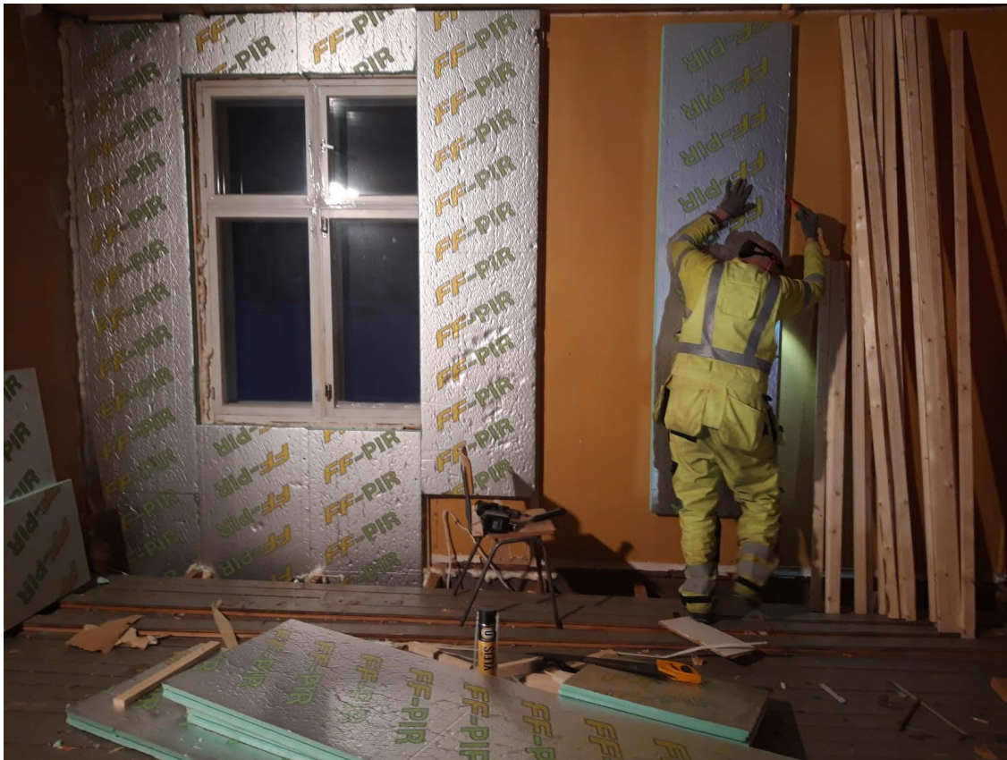
Kuva 7; Ulkoseinien lisäeristys FF-PIR-levyillä ja ilmaraolla.
