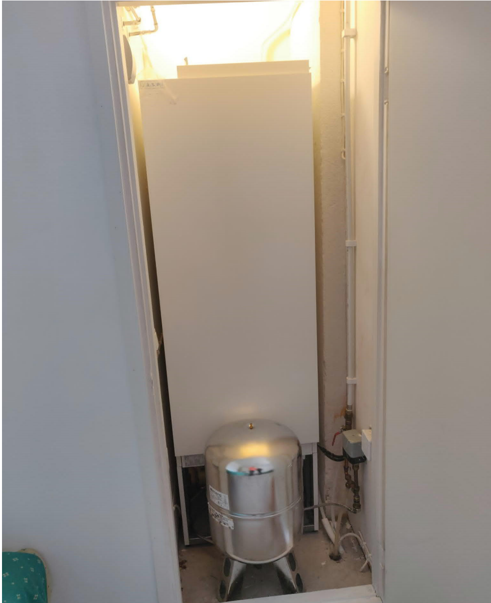
Kuva 6; Uusi lämminvesivaraaja
