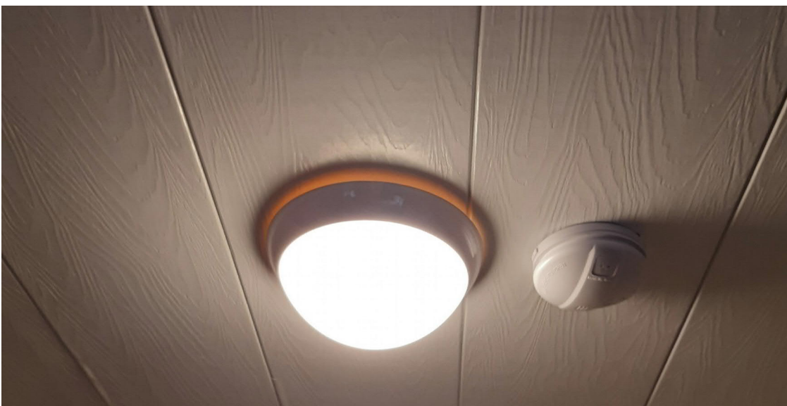
Kuva 8; Keskitetty Palohälytinjärjestelmä
