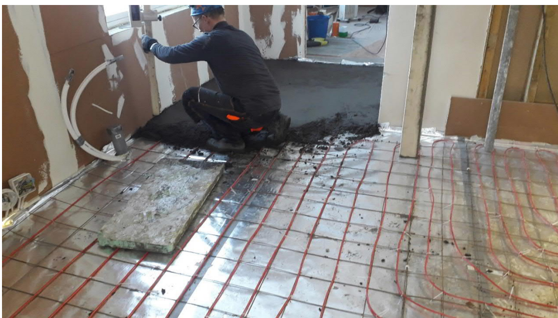
Kuva 3; Asennettu lattialämmitys ja lattioiden oikaisu valamalla (min 30 mm).
