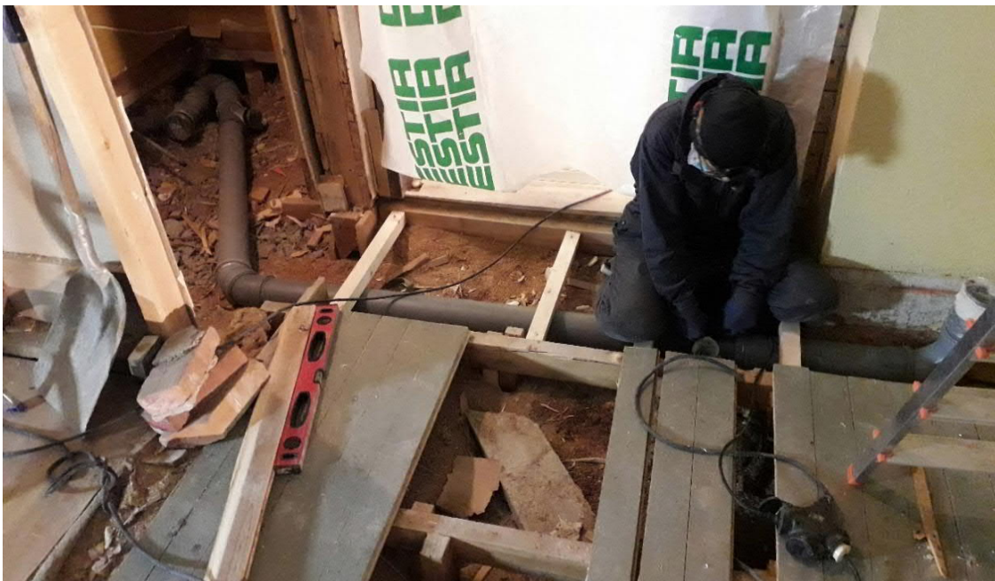
Kuva 1; Uudet vesi- ja viemäriputkistot
