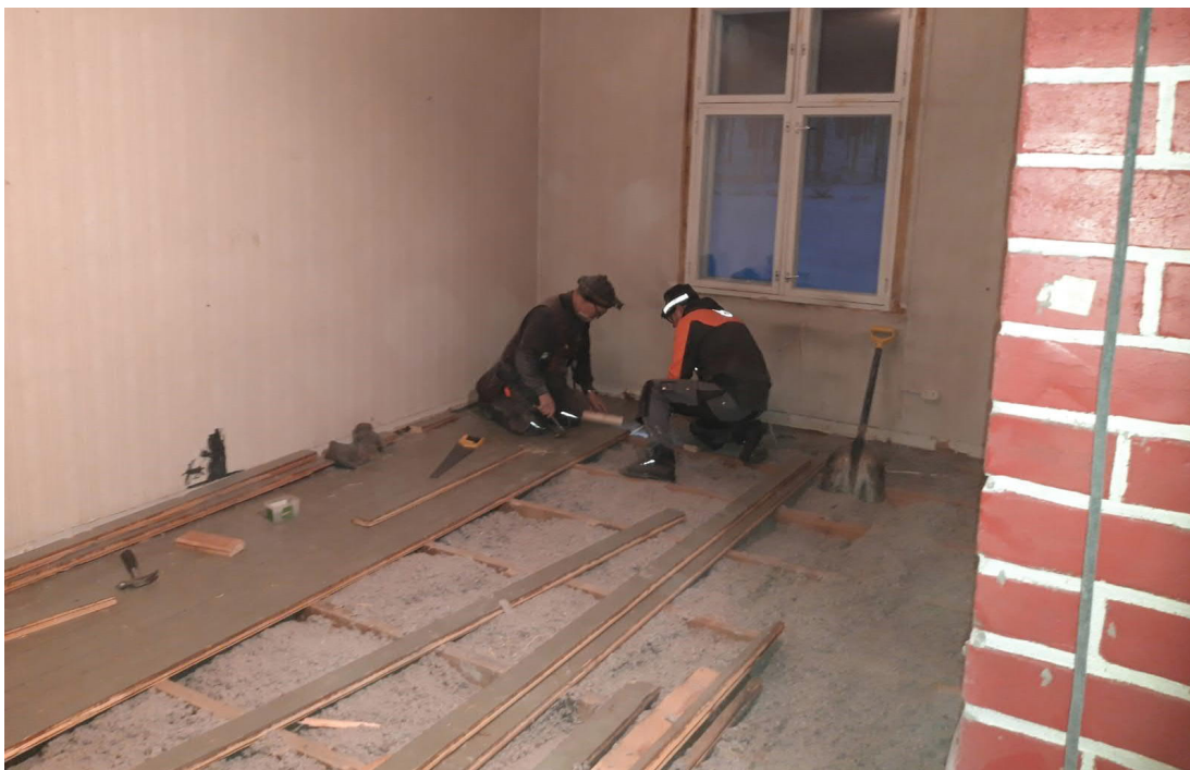
Kuva 2; Lattioiden lisälämpöeristys; puhallusvillalla
